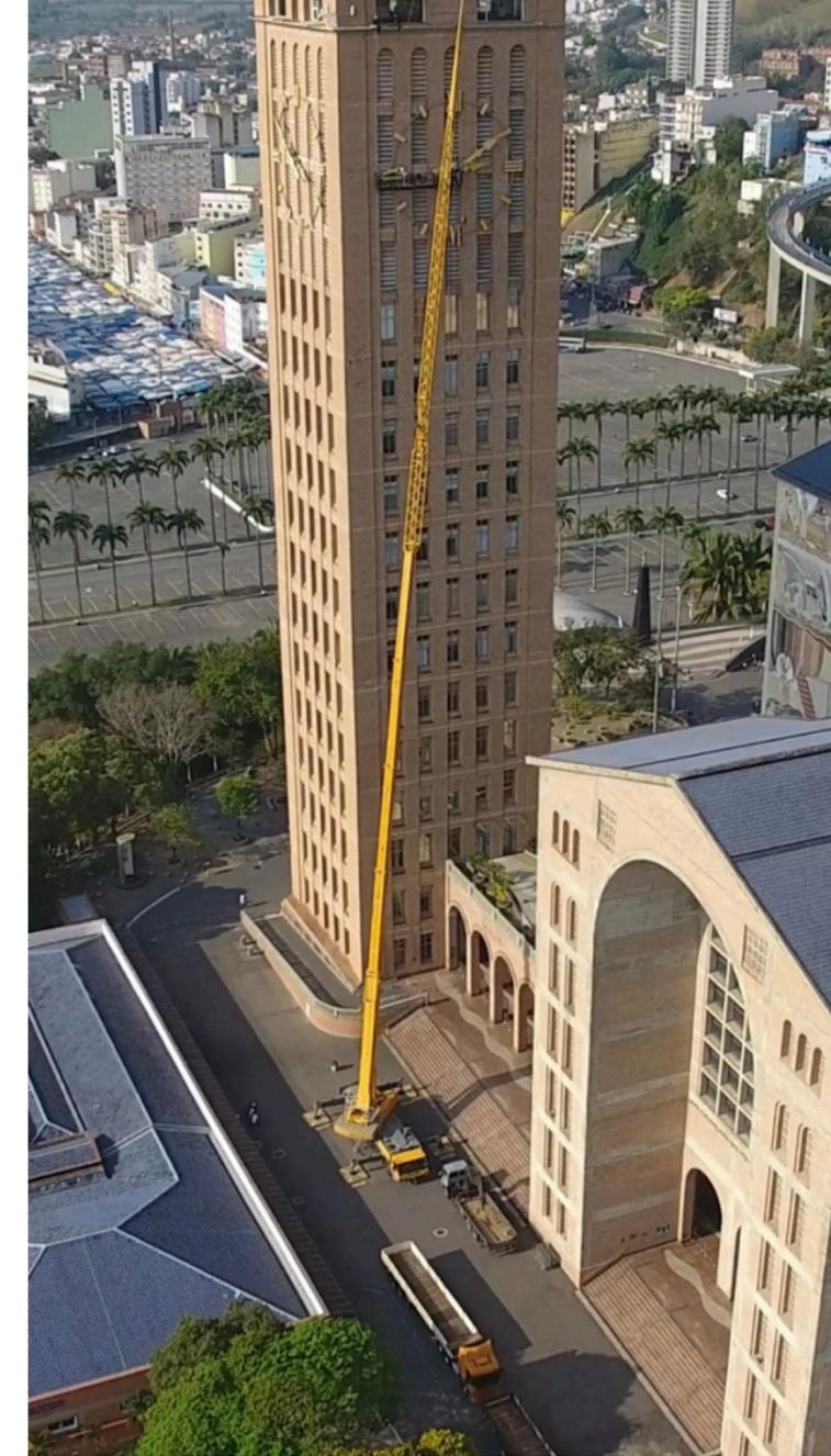
Projeto de rigging para remoção ponteiros do relógio do Santuário de Aparecida para retificação da máquina.
